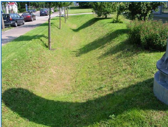
Exemple d'aménagements de fossés enherbés en zone urbaine
