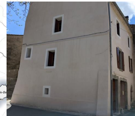
Réhabilitation dans le centre-village de Saint-Jean-de-Buèges – Photo GTC, mai 2021
