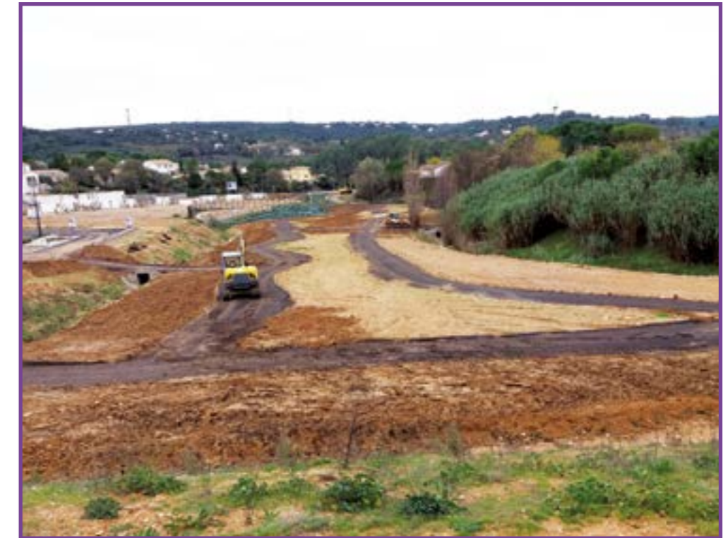
Les travaux de la coulée verte
