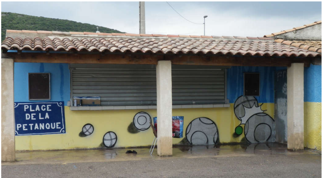
Un nouveau look pour le local pétanque
