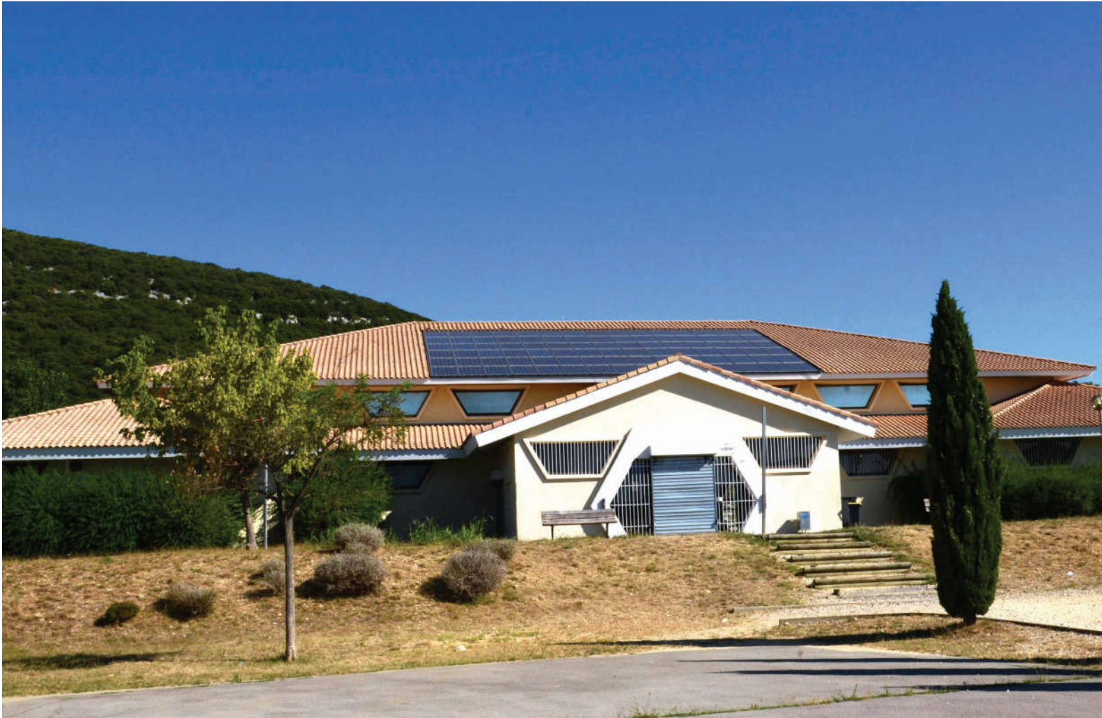
Panneaux photovoltaïques de la salle polyvalente
